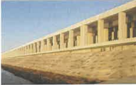
Galería de Protección del Puerto Exterior de Punta Langosteira (La Coruña)
