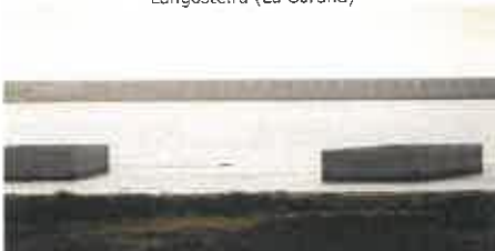
Cajones de hormigón Ampliación puerto de Aberdeen (La Coruña)
