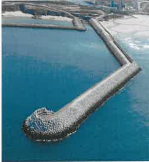
Dique Oeste Puerto Punta Langosteira (La Coruña)
