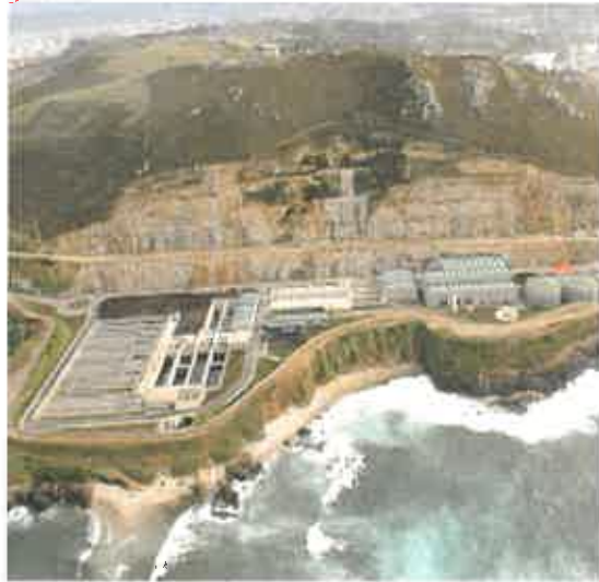
Estación depuradora de aguas residuales de Bens (La Coruña)
