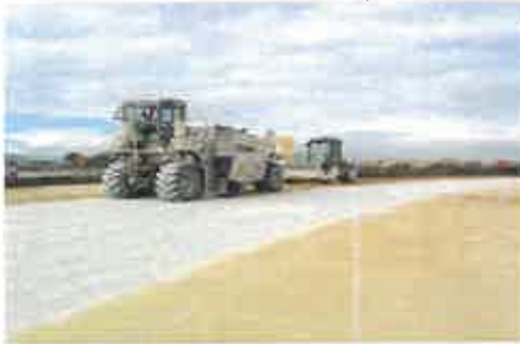
Autovía del Cantábrico. Tramo Barres-Ribadeo. Asturias.
