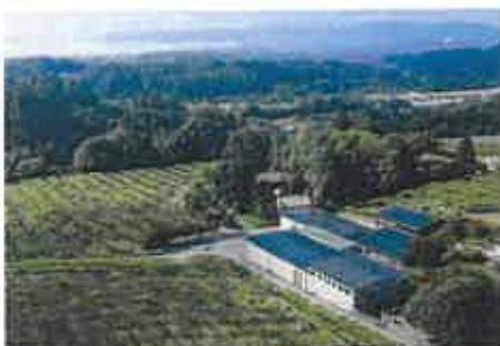
Instalación fotovoltaica Bodegas Fillaboa.
