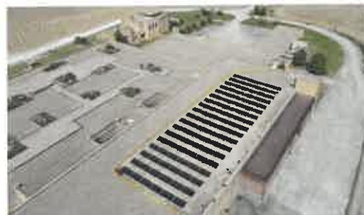
Instalación fotovoltaica Bodegas Pagos de Araiz
