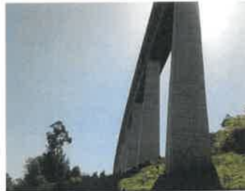
Línea de alta velocidad Santiago-Orense. Tramo Vedra-Boqueixón. Galicia
