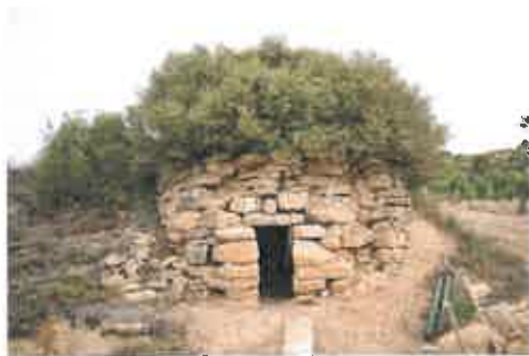
Chozo antes de la rehabilitación
