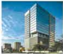
Adquisición Edificio "2200 West Oaks" en Houston
