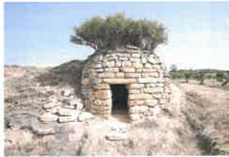
Chozo después de la rehabilitación
