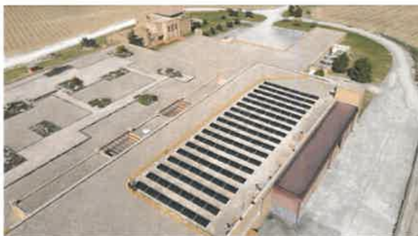
Instalación fotovoltaica Bodegas Pagos de Araiz
