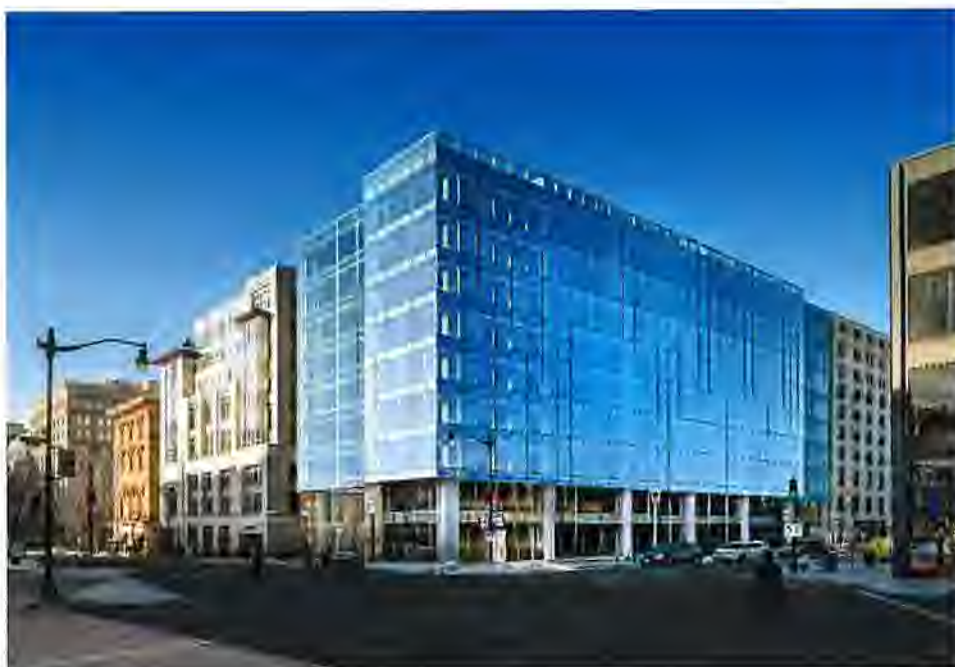
Imagen Edificio 900 G (Washington)
