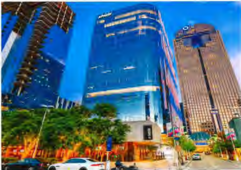
Imagen Edificio 900 G (Washington)
